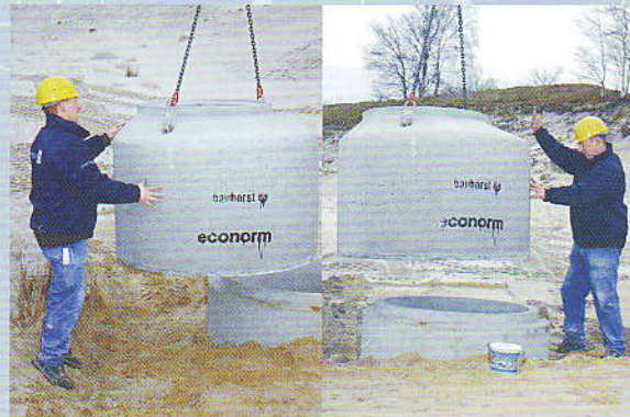
Das Verlegen der econorm Schachsystemteile mit dem formschlüssigen Verlegeanker econorm-plus , von bauhorst .....
